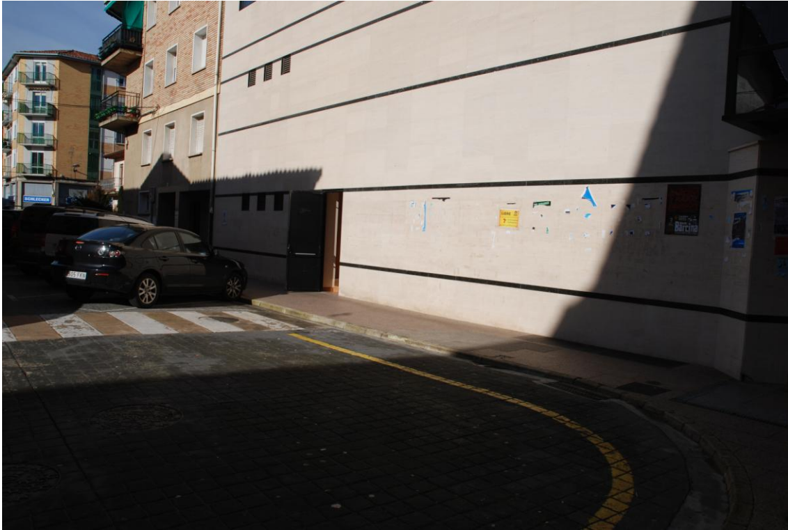
ACCESO CARGA DESDE LA CALLE
