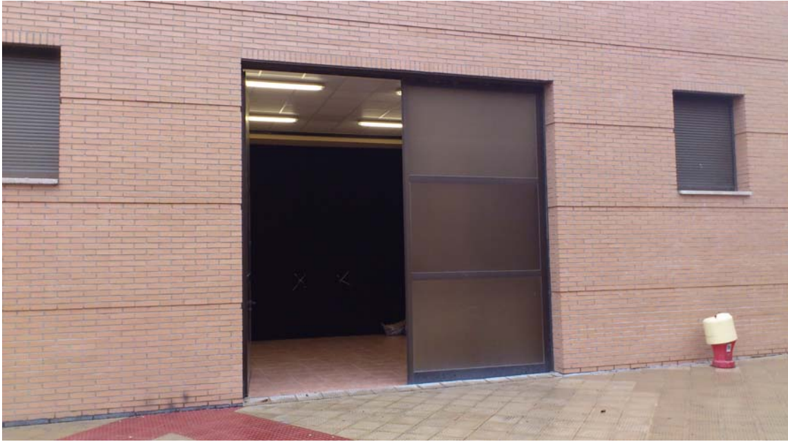
ACCESO CARGA DESDE LA CALLE
